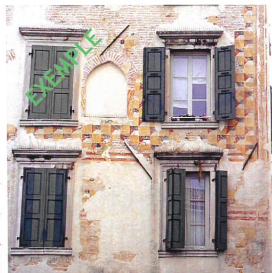
Il arrive qu'on doive procéder à l'intégration de détails d'époques différentes sur une façade jusque là "homogène". On distingue ici un reste de parement médiéval en brique, avec une ouverture en ogive (murée) les restes d'un décor peint (également médiéval). La façade hier encore XIXe raconte maintenant son histoire.
