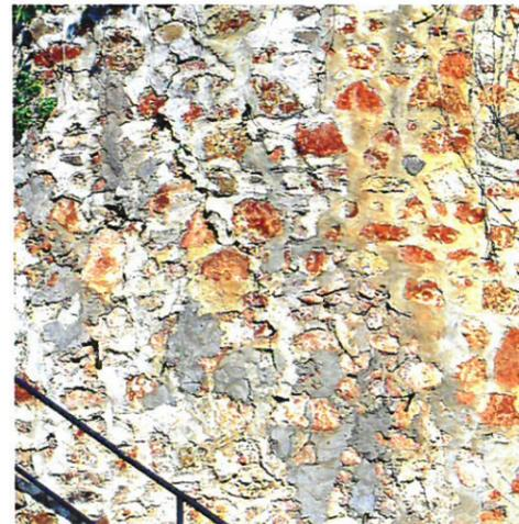
2. L'utilisation du ciment s'est souvent révélée catastrophique pour les maçonneries anciennes (ici un soubassement d'une tour de l'enceinte du XVe siècle), que ce soit visuellement, comme techniquement. En rendant les joints étanches, le ciment accélère la dégradation de moellons de qualité médiocre, par remontée d'humidité.
